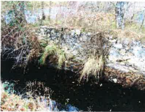
CANAL DE RESTITUCIÓN
