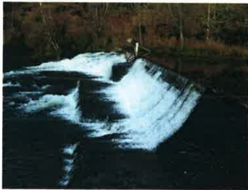
AZUD DE TOMA. VISTA DESDE LA MARGEN IZQUIERDA
