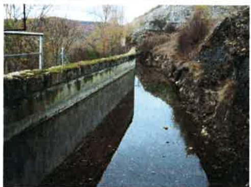
TRAMO FINAL DEL CANAL DE DERIVACIÓN
