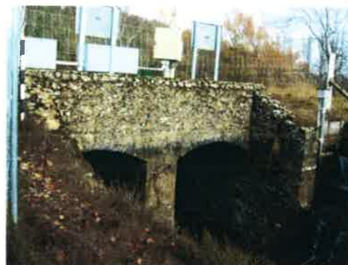
OBRA DE TOMA DESDE AGUAS ABAJO
