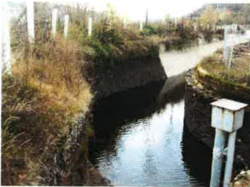
TRAMO INICIAL DEL CANAL DE DERIVACIÓN.
