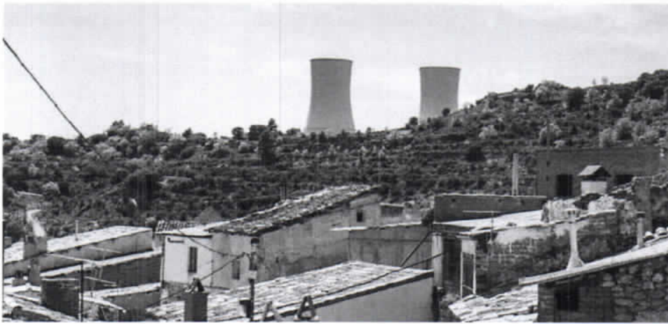
El pueblo de Trillo, con las chimeneas de la central nuclear de fondo. (D. B.)
