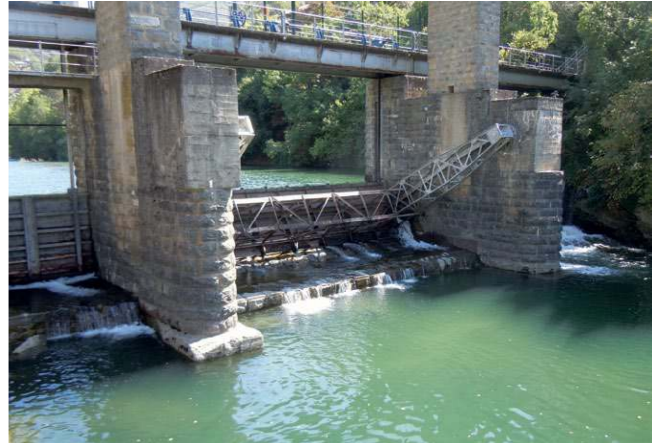
Azud de toma de la central de Argoné (FIG. 26).
