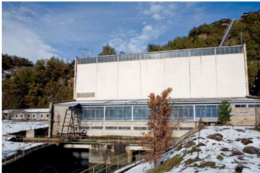
Canal de desagüe de la central de Lanuza (FIG. 64).
