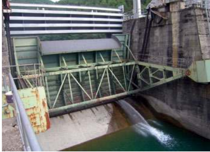
Compuerta Taintor con vertedero superior (FIG .42). (dcha.) Presa de Laspuña con 3 grandes compuertas Taintor (FIG. 41).
