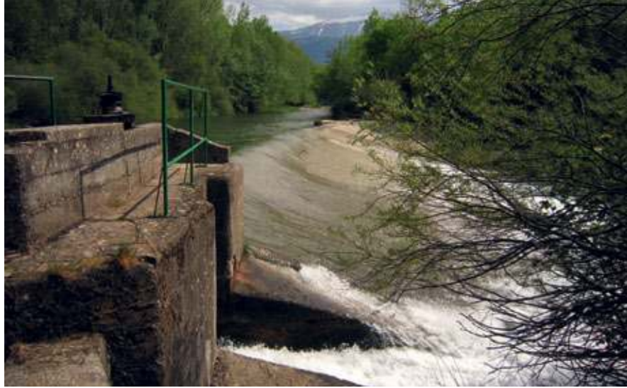
Toma de la central de Aratorés en el río Aragón (FIG. 18).
