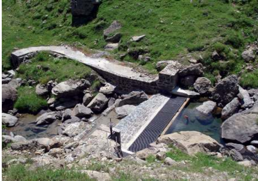
Toma autolimpiable recién construida en el barranco de Las vacas, a la que llega por la margen derecha el agua del barranco de Goluso, que añadida a la de Las Vacas es canalizada a Tramacastilla por la margen izquierda (FIG. 51).
