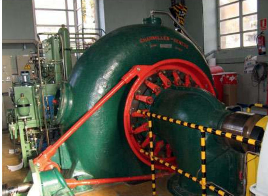
(arriba) Central de Bielsa con el caracol, distribuidor y su accionamiento originales (FIG. 20).
