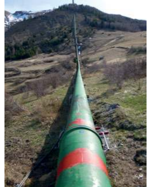
Tubería de la central. Pueden verse varios machones de anclaje y la chimenea de equilibrio (FIG. 52).
