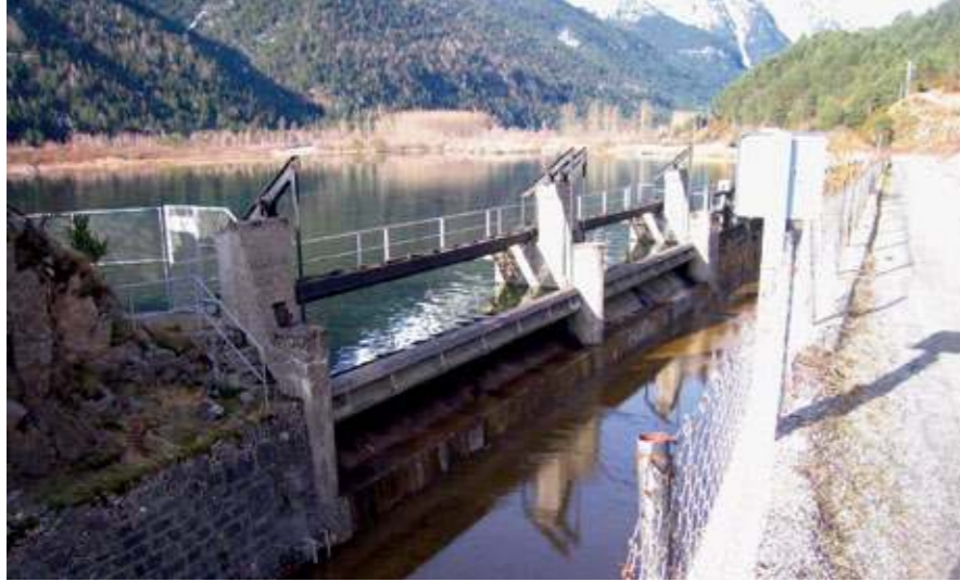
Clapetas abatibles y compuertas verticales de la presa de Pineta (FIG. 22). (dcha.) Aliviadero de Pineta casi anegado en avenida, con las clapetas abiertas y vertiendo por todas las compuertas (FIG. 23).
