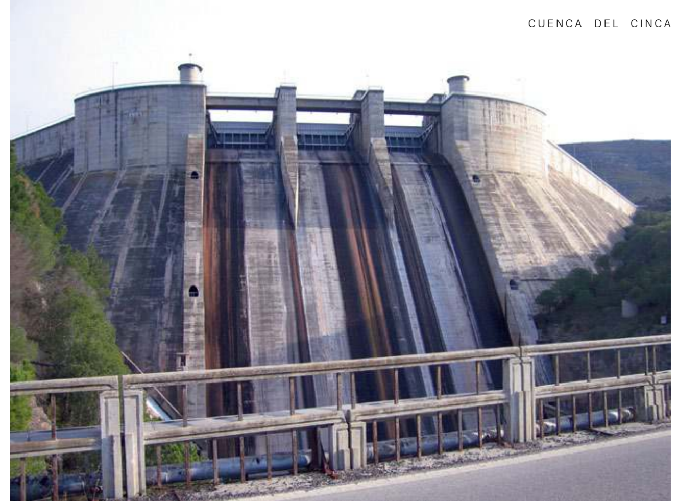
Aliviadero de gravedad con compuertas en la zona central de la presa (FIG 52).
