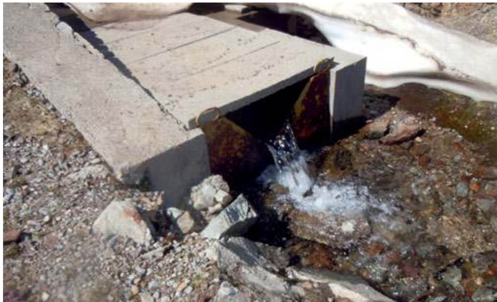
Aforo de filtraciones de la parte derecha de la presa de Urdiceto con el embalse en la cota +2.357,50 (FIG. 12).
