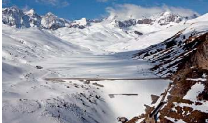
Presas de Escarra en invierno. La ladera Sur apenas tiene nieve (FIG. 45).
