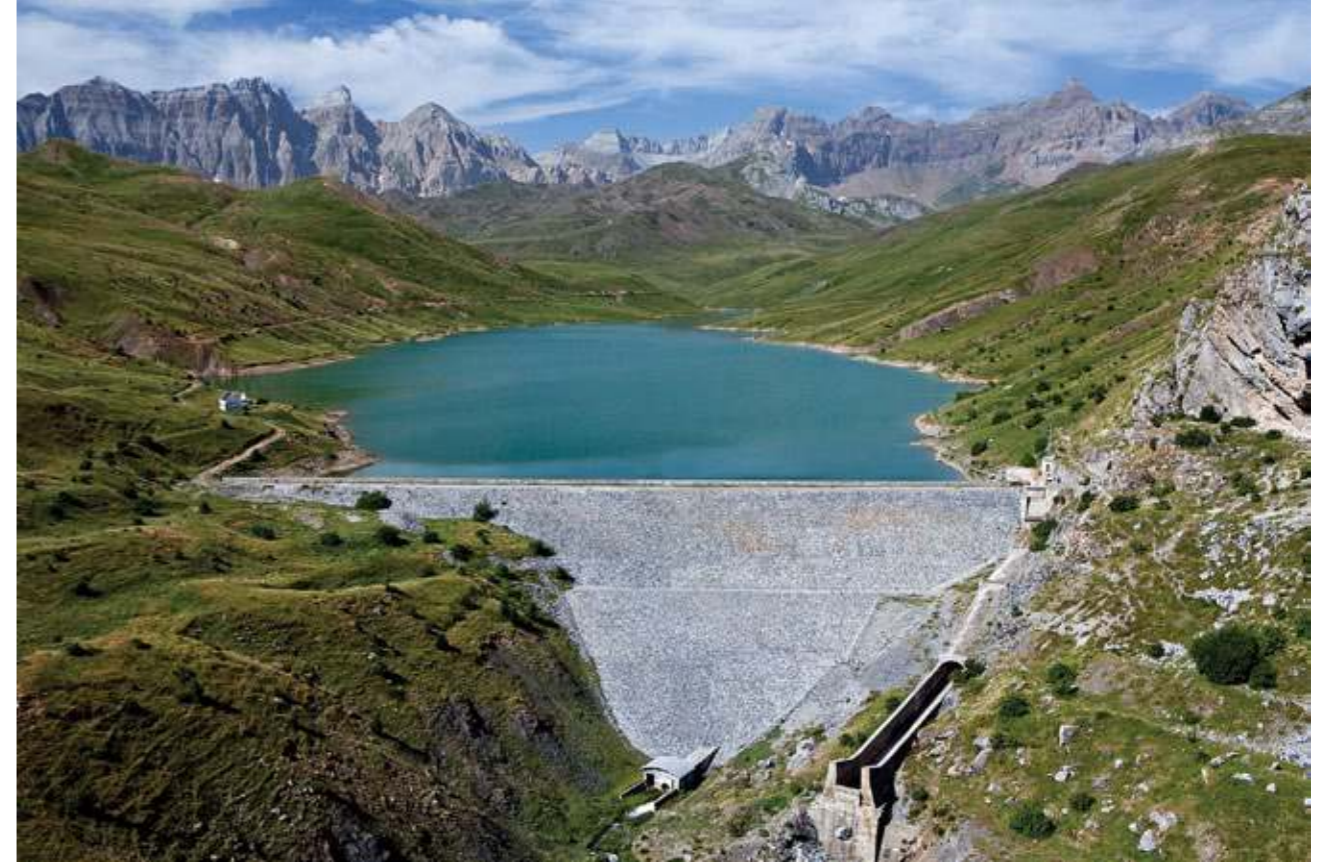
Presas de Escarra con el estribo izquierdo en roca y el derecho en un deslizamiento (FIG. 44).
