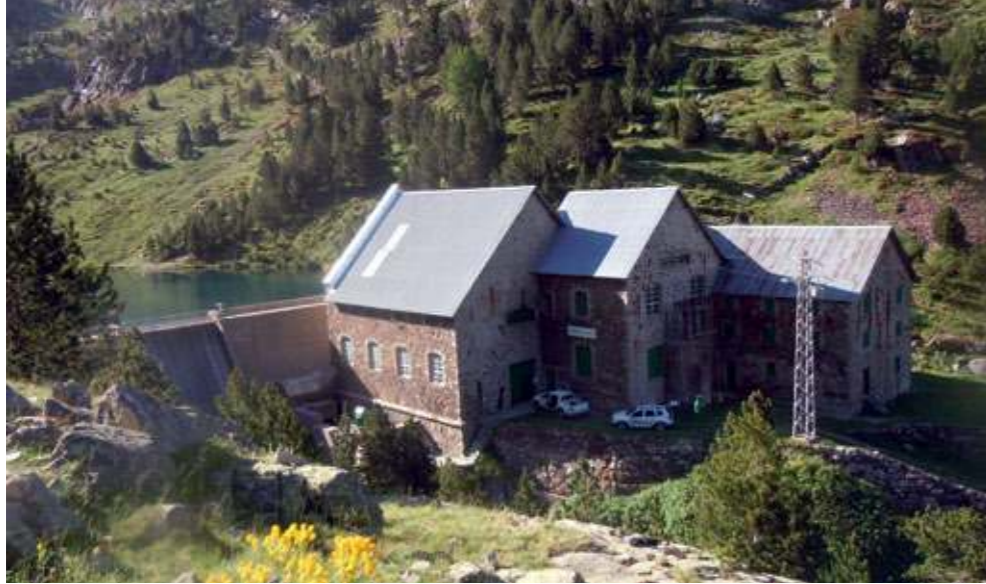
Embalse de Baranetas y Central de Urdiceto, de generación y de bombeo (FIG. 13).
