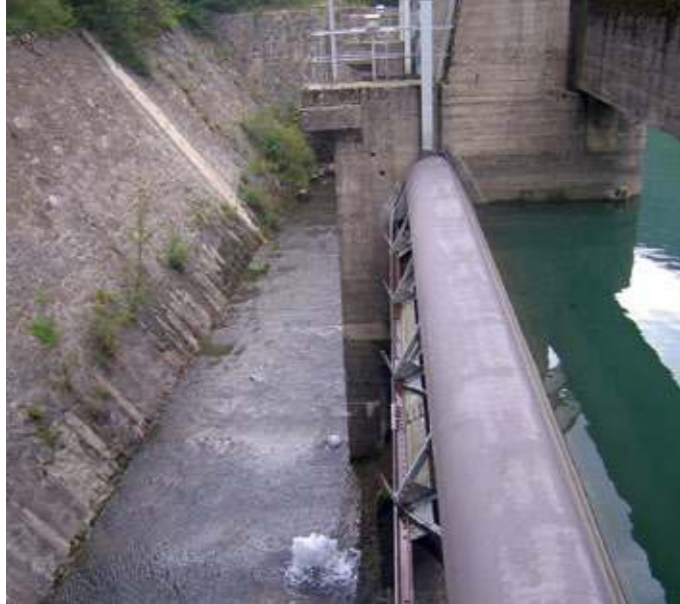
Aliviadero de clapetas abatibles de Plandescún (FIG. 27). (dcha.) Presa de Plandescún (FIG. 26).
