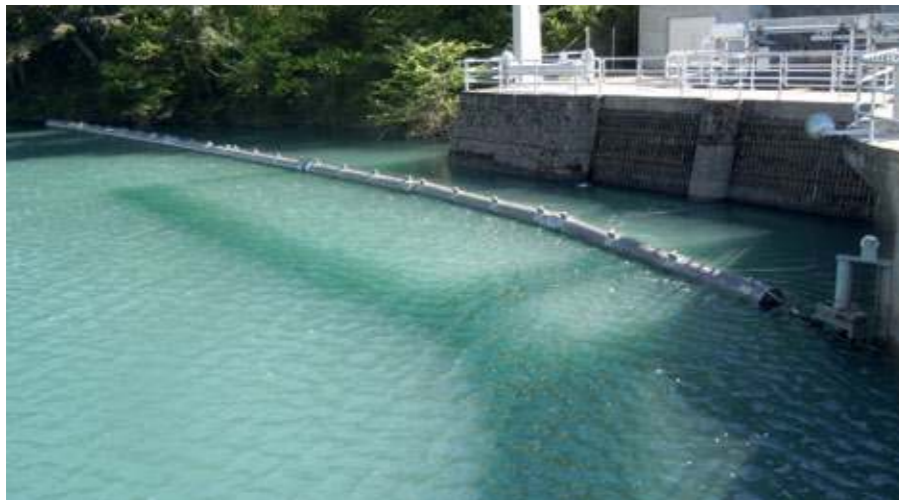
Presas de Laspuña cuya toma requiere tener las compuertas cerradas. Puede verse el flotador para desvío de flotantes (FIG. 13). (dcha.) Compuertas de Paso Nuevo cerradas (FIG. 14).
