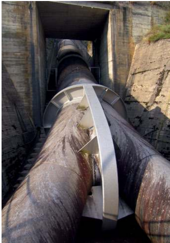
Bifurcación de la tubería en la llegada a la central (FIG. 44). (dcha.) Interior de la central de Laspuña, con dos grupos turbinas Francis de eje horizontal (FIG. 47).
