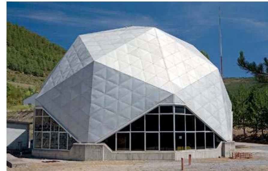
Central de Jaca con figura de poliedro y tubería de llegada de agua (FIG.24). Central de Jaca con figura de poliedro (FIG. 25).
