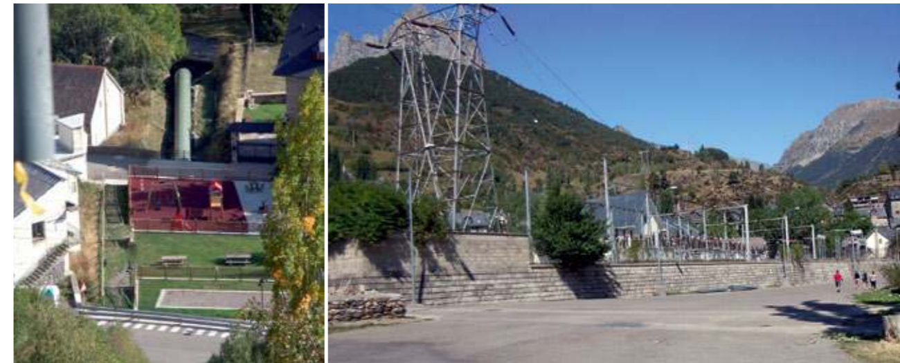
Tubería de La Sarra enterrada al llegar al núcleo urbano (FIG. 42). Subestación de la central de Sallent (FIG. 43).
