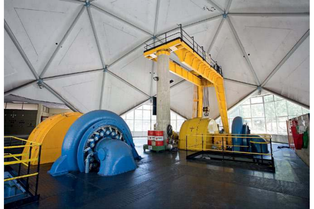
Interior de la central de Jaca con puente grúa circular y apoyo central (FIG. 26).
