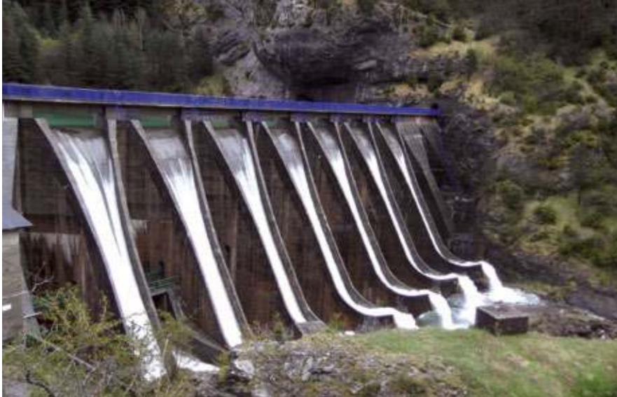
Presa de Canfranc, vertiendo por los aliviaderos situados sobre los contrafuertes (FIG. 08).
