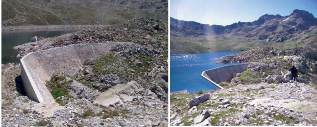
(arriba) Presa de Brazato Collado. Obsérvese la distancia al nivel del agua (FIG. 13). Brazato Collado con el embalse lleno. El aliviadero está en el extremo izquierdo (FIG. 14).
