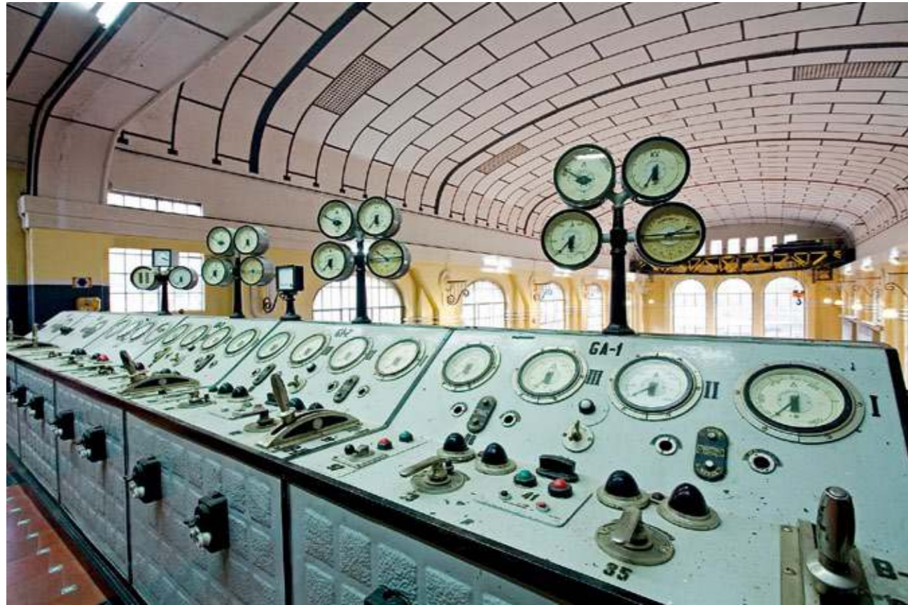
Central de Seira, cuadros de control (FIG. 23).
