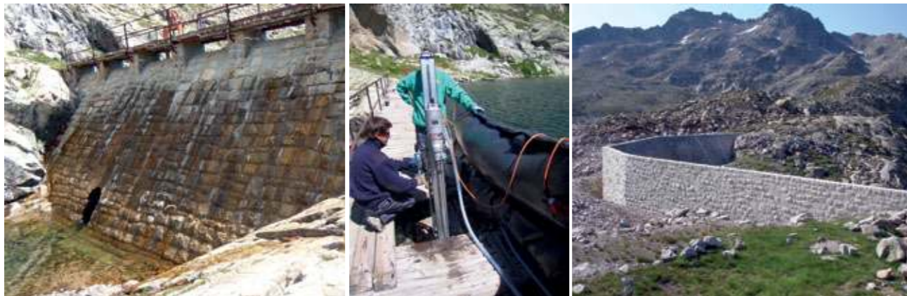
Filtraciones en el paramento de Bachimaña Inferior (FIG. 01). Inyectando en la presa de Bachimaña Inferior (FIG. 02). Paramento de Brazato Collado revestido de poliuretano (FIG. 03).
