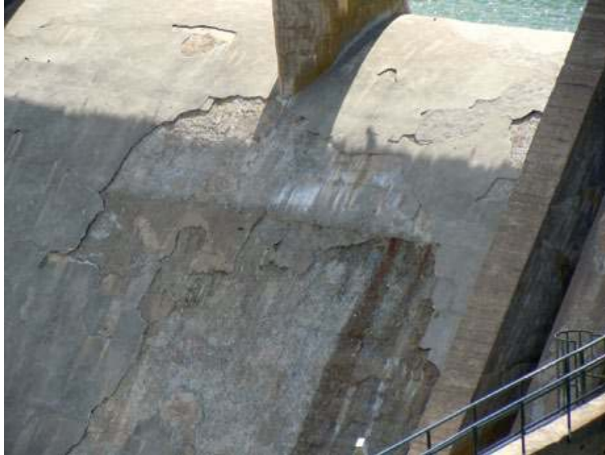
Aliviadero de la presa de El Gállego deteriorado por erosión de los arrastres (FIG. 39).
