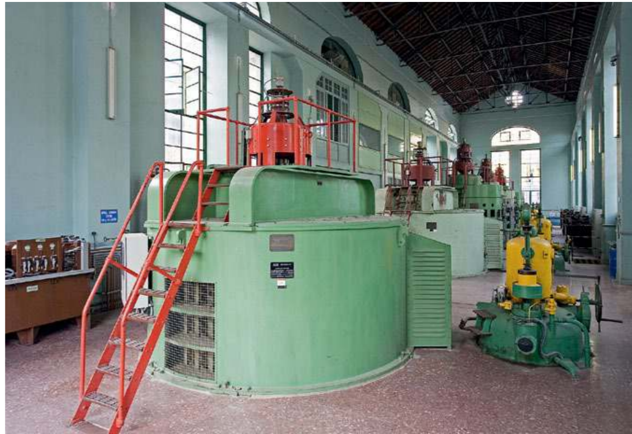
Interior de la central de Lafortunada con sus 5 grupos (FIG. 35).
