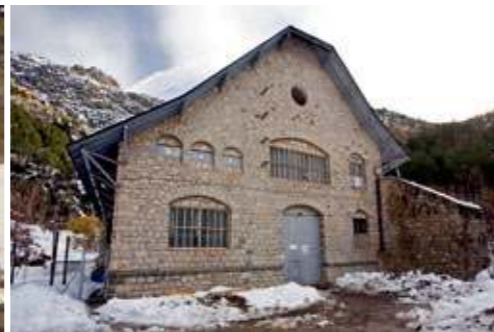
Edificio de la Central de Baños (FIG 18).
