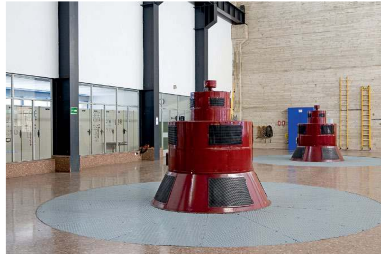
Interior de la central de Lanuza con los dos alternadores sobre las turbinas Francis de eje vertical (FIG. 65).
