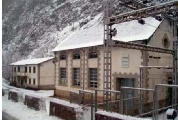
Central de Salinas, subestación y edificio de antiguas viviendas (FIG. 40).
