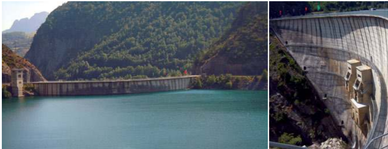
Embalse de Lanuza. Se mantiene lleno hasta agosto para facilitar los festivales de Pueyo de Jaca (FIG. 61). (dcha.) Presa bóveda de Lanuza (FIG. 60).
