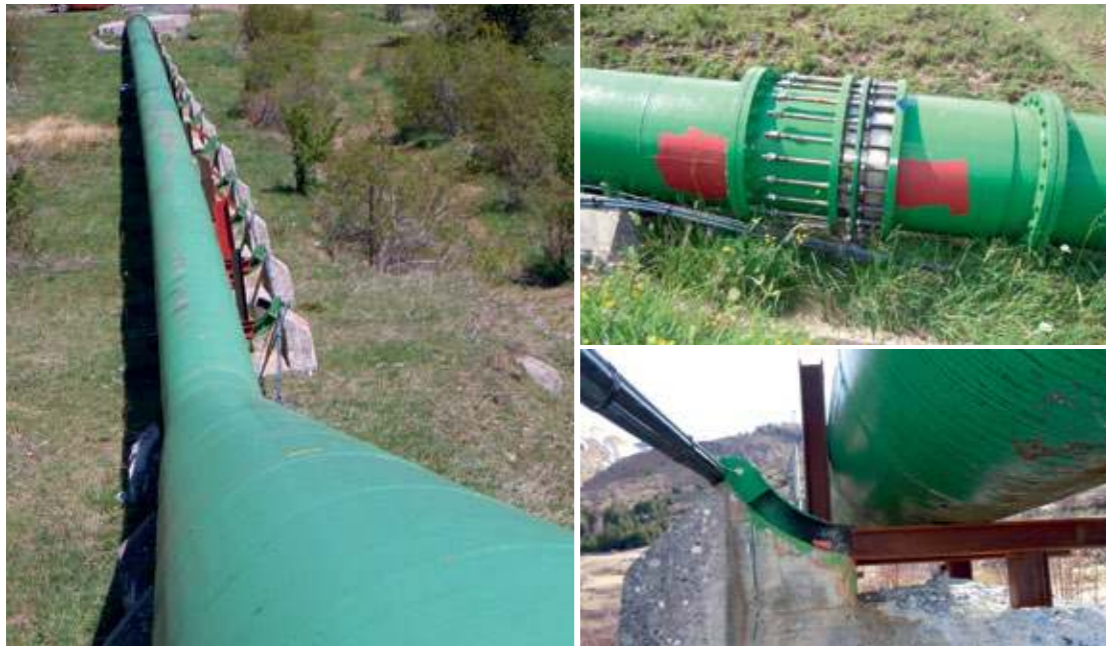
Tramo en que la ladera se desplaza hacia abajo y hacia la derecha, apreciándose el movimiento de los apoyos (FIG. 53). Junta de dilatación que transmite tracciones y tiene gran longitud de movimiento (FIG. 55). Se mantiene la alineación de la tubería prolongando los apoyos (FIG. 54).
