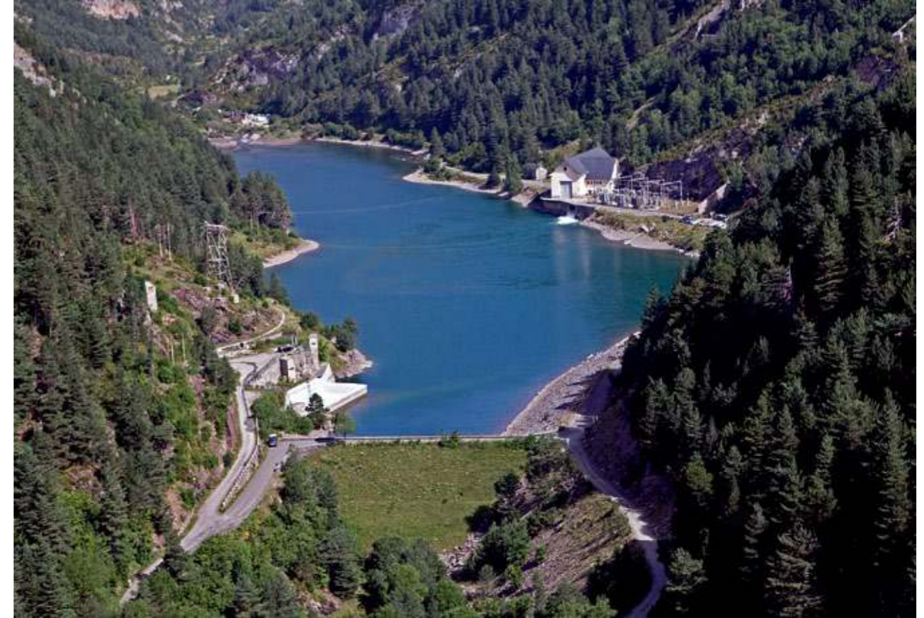
Presa y embalse de La Sarra. Al fondo la central de La Sarra (FIG. 34).
