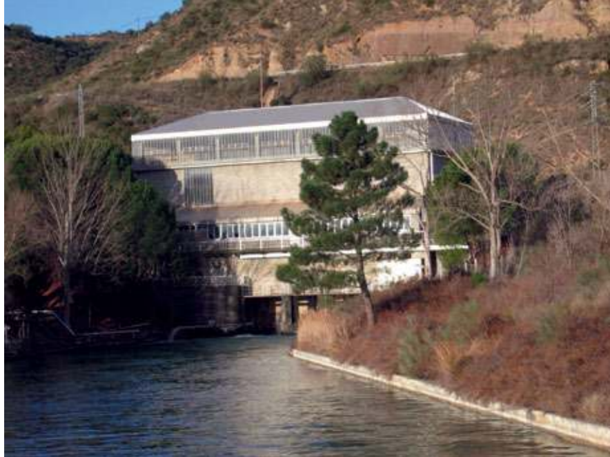
Canal de desagüe de la central de Grado II (FIG. 58).
