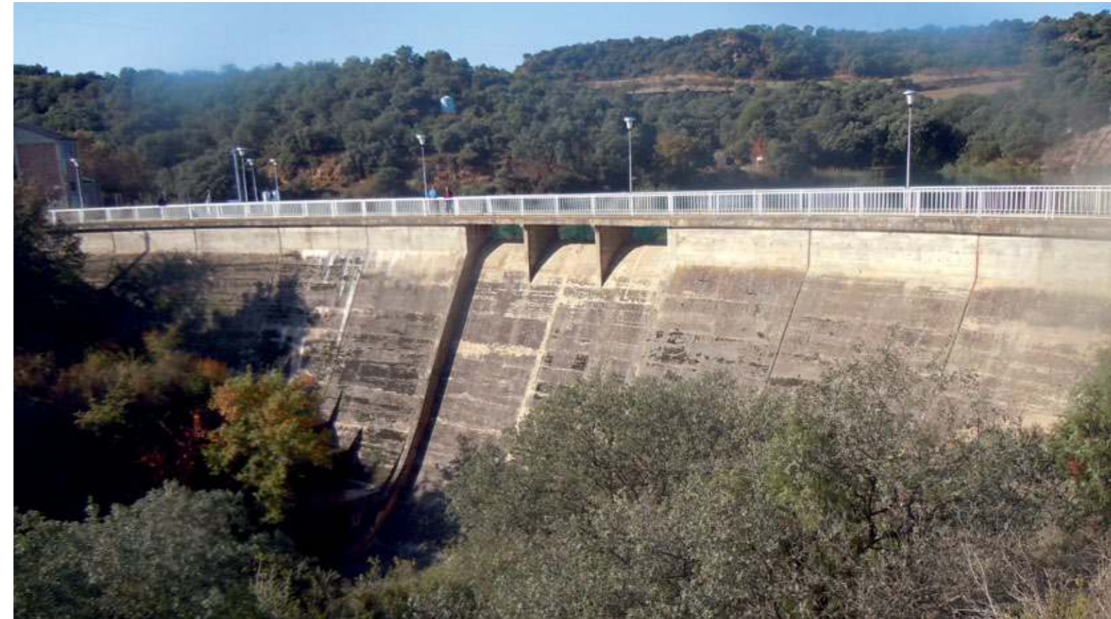
Presa en la toma de la central de Grado II (FIG 55).
