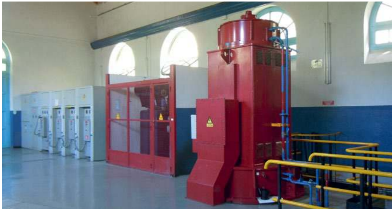
Interior de la central de Castiello de Jaca, con el grupo, equipos eléctricos y transformador (FIG. 21).
