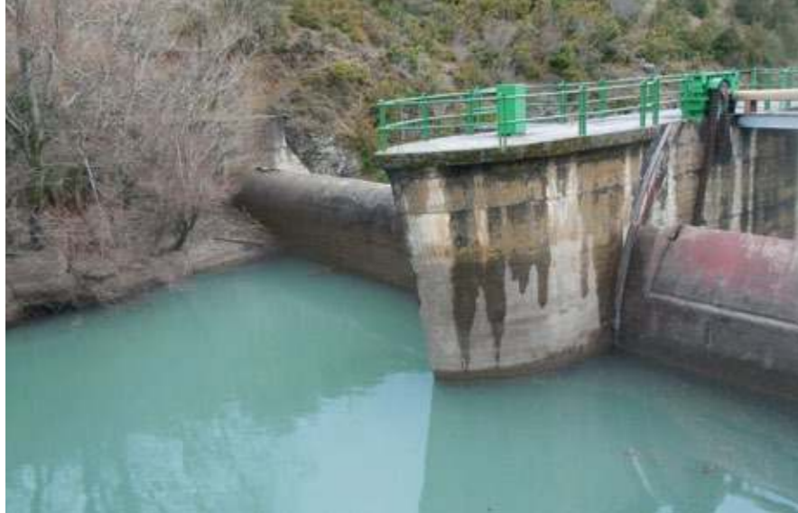
Presa de la central de Jaca, con un vano de labio fijo y otro con compuerta Taintor y clapeta (FIG. 22).
