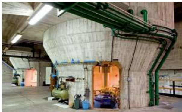
Estructura de soporte del piso de generadores con el eje de la transmisión en el interior (FIG. 67).
