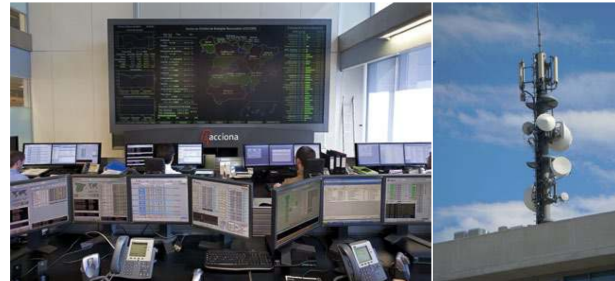
Sala de control del CECOER (FIG. 02b). Antena de comunicaciones del edificio de Acciona Energía en Sarriguren, Navarra (FIG. 03b).
