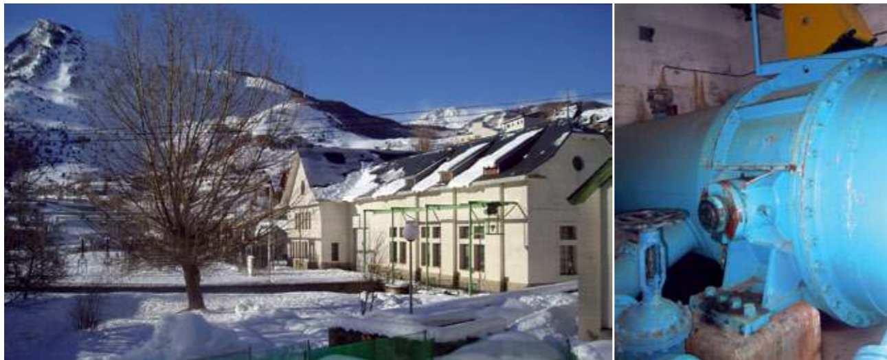
Central de Sallent y Escarra (FIG. 41). Válvula de mariposa de cierre automático en sobrevelocidades de la tubería (FIG. 40).
