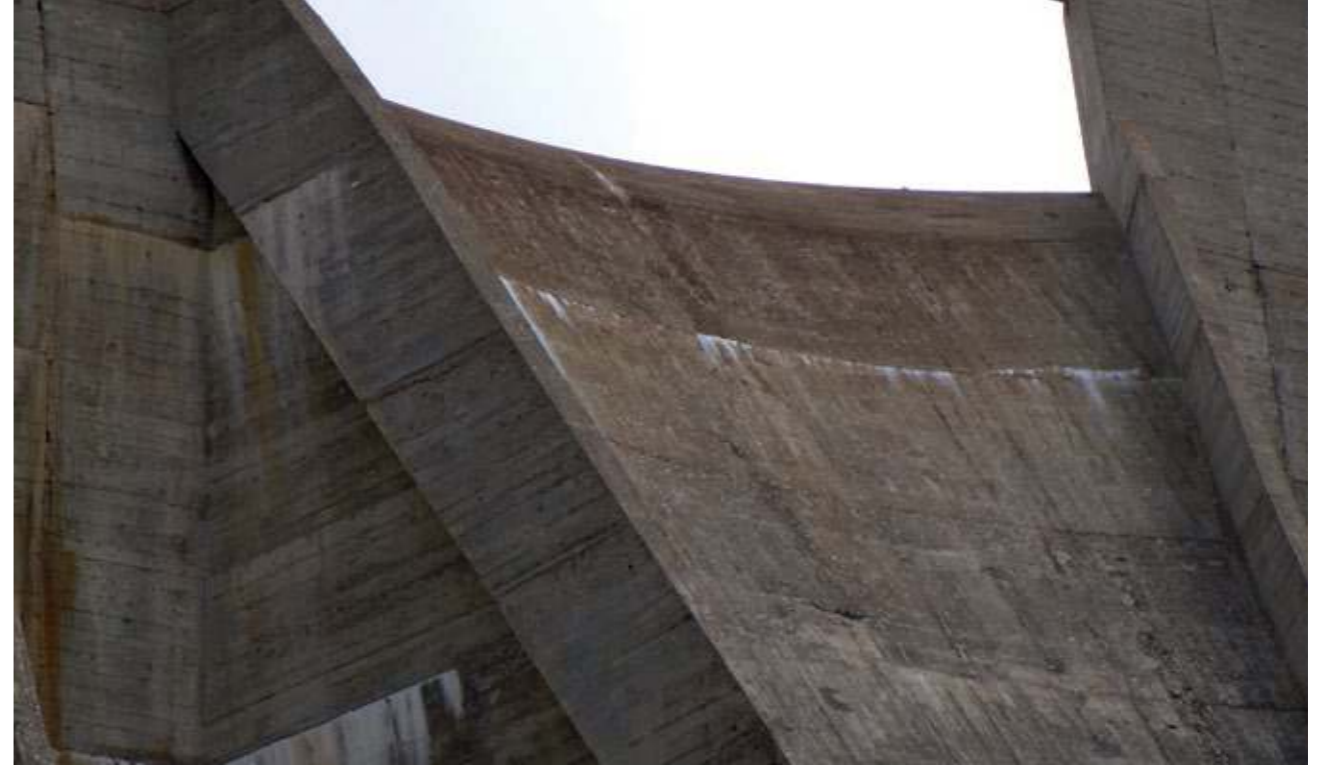
Véase el perfecto estado de las aristas de los contrafuertes (FIG. 31).
