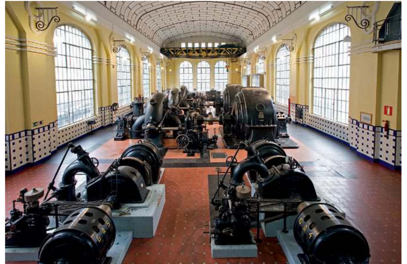
Central de Seira, interior de la nave de turbinas y generadores (FIG. 22).
