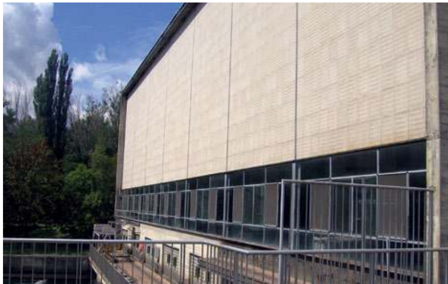
Central de Eriste, exterior (FIG. 11).
