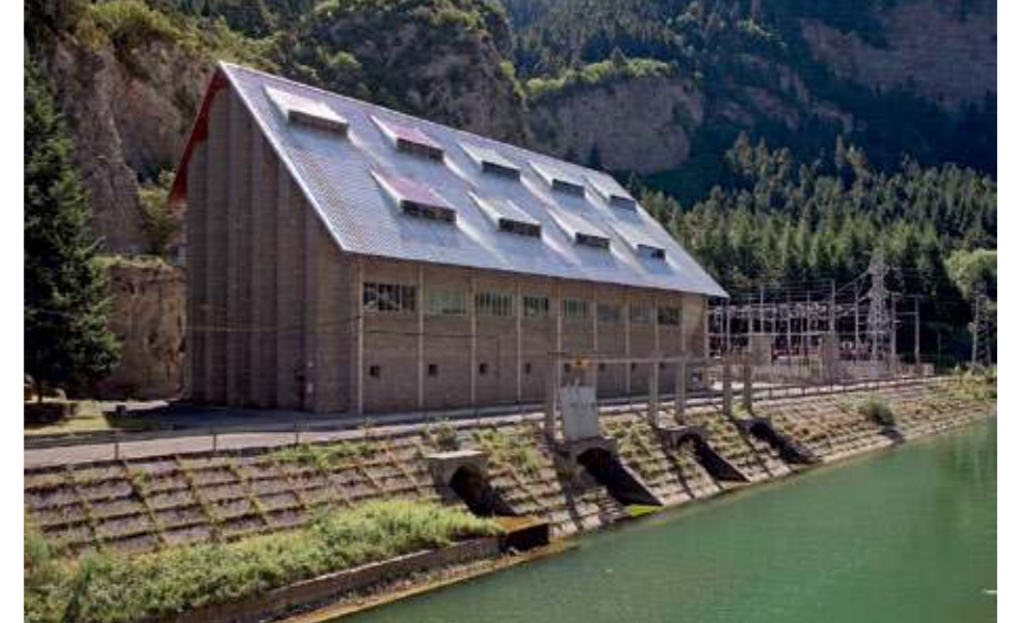
Central de Ip y embalse de Canfranc en el que se vierte al turbinar y desde el que se aspira para bombear. Puede verse que el nivel del agua está por debajo de la cota de la solera de la central (FIG. 13).
