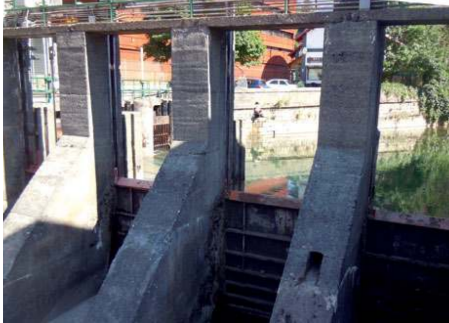
Vertido de la cámara de carga al embalse de Canfranc (FIG. 15).
