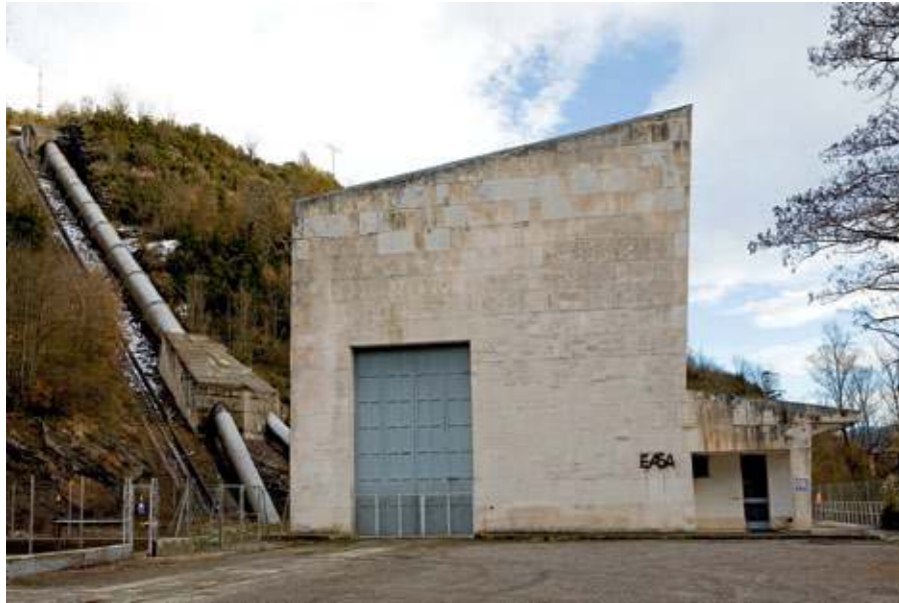
Exterior de la central de Sesué (FIG. 17).
