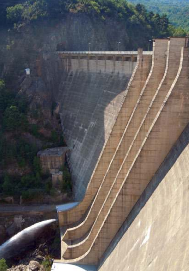
Presa de Bupal, de arco gravedad, vertiendo el caudal ecológico (FIG. 69).
