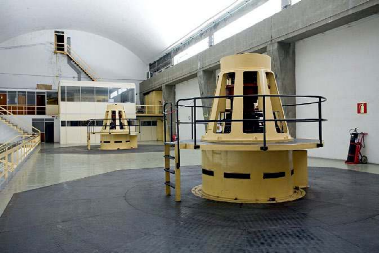
Central de Mediano, excavada en la roca (FIG 49).
