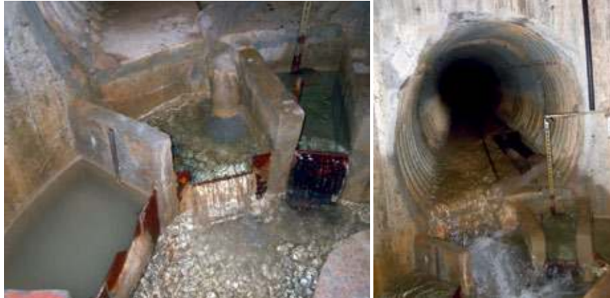
Filtraciones en la galería con el embalse en la cota +2.102. El piso de la galería está seco (FIG. 06). (dcha.) Filtraciones con el embalse a la cota +2114,60. Puede verse el tubo ARMCO de la galería sobre cuyo fondo circula agua de filtraciones (FIG. 07).
