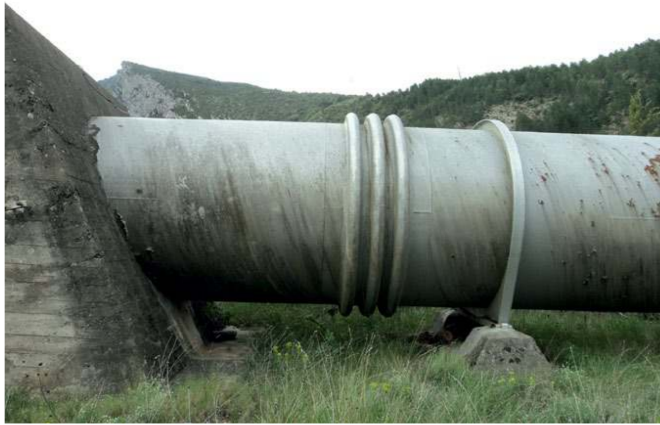
Junta de dilatación de onda en la tubería de la central de Argoné (FIG. 29). (dcha.) Interior de la central de Argoné (FIG. 28).
