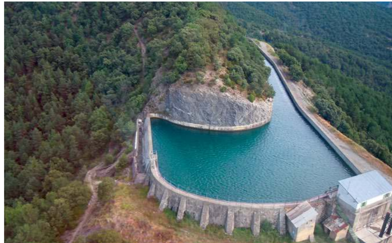
Cámara de carga de la Lafortunada Cinca a 454 m sobre el río (FIG. 31).
