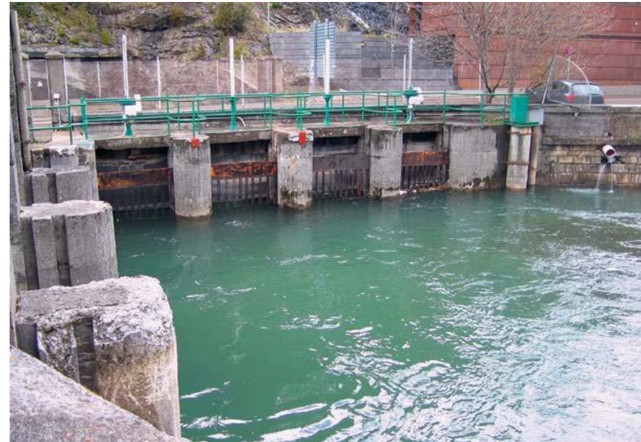
Toma de la central de Villanúa en el desagüe de la central de Canalroya (FIG. 14).
