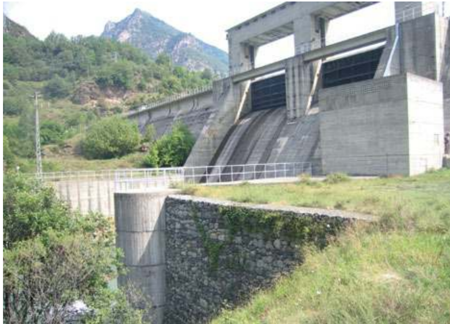
Presa de Línsoles (FIG. 15). (dcha.) Vertido por la válvula de mariposa (FIG. 16).
