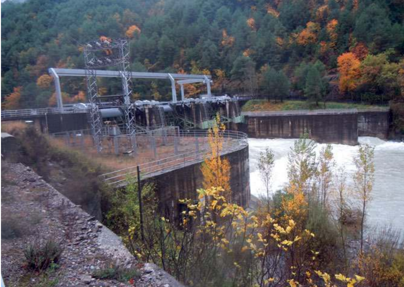
Vertiendo con las tres compuertas abiertas (FIG. 43).
