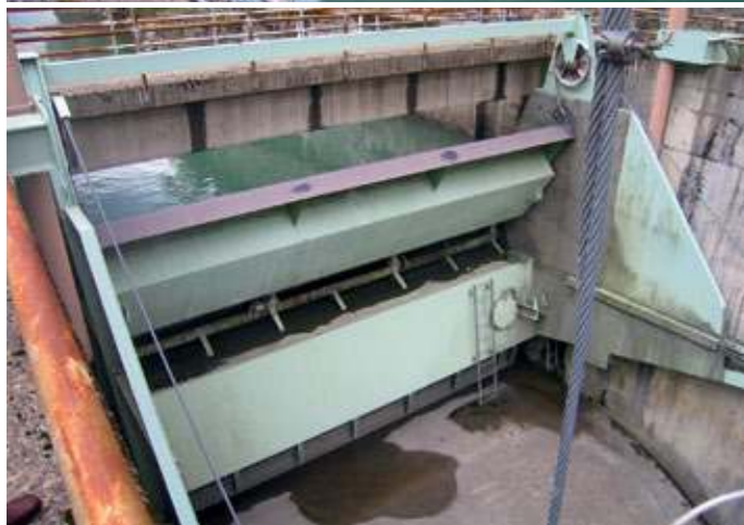
Aliviadero del estribo izquierdo de Plandescún (FIG. 28). Compuerta Taintor con clapeta superior de Plandescún (FIG. 29).
