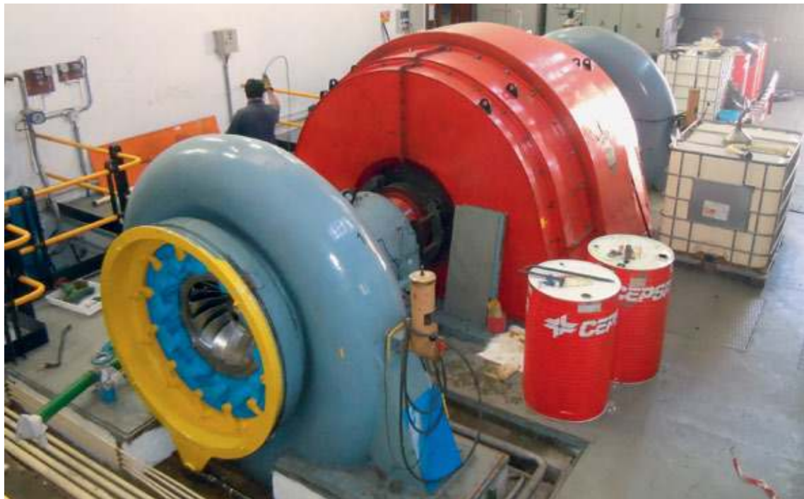
Interior de la central de Canalroya. Puede verse el rodete de una turbina que se está revisando (FIG. 02).
