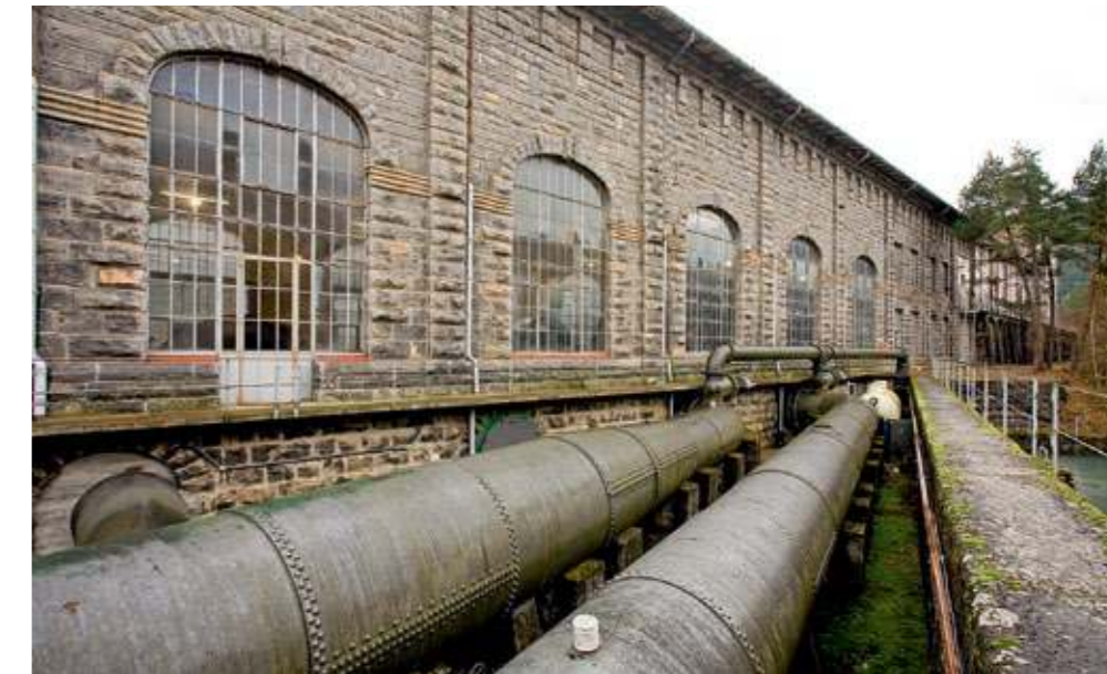
Central de Seira, nave de turbinas y tuberías de llegada de agua (FIG. 25). (izda.) Embocadura de salida del primer túnel del canal de Seira (FIG. 21).
