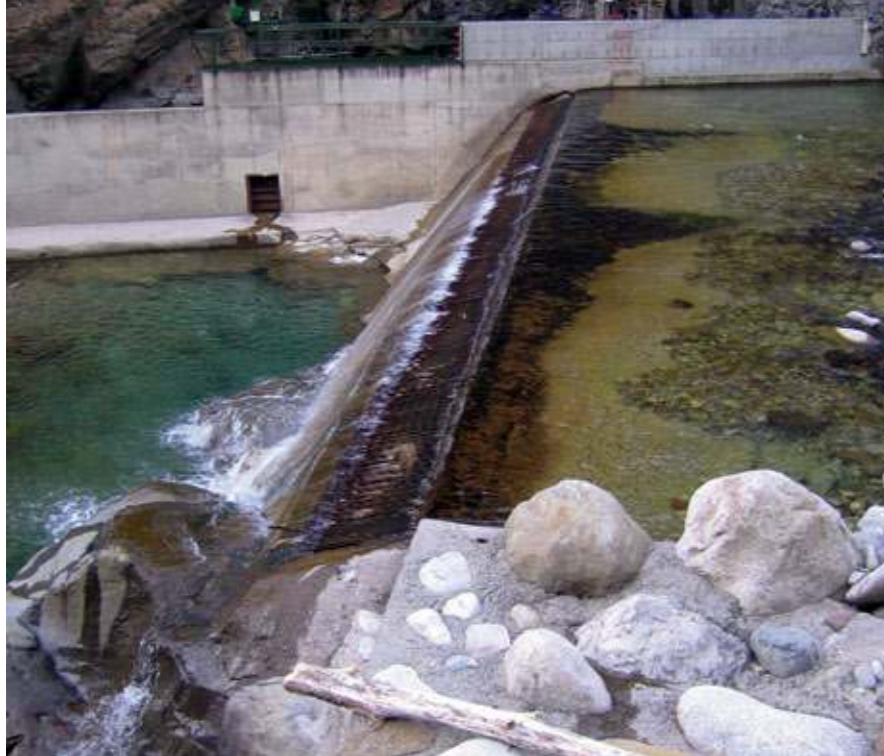
Azud de Salinas con toma autolimpiante (FIG. 38). (dcha.) Escala de peces de Salinas, adecuada al entorno (FIG. 39).
