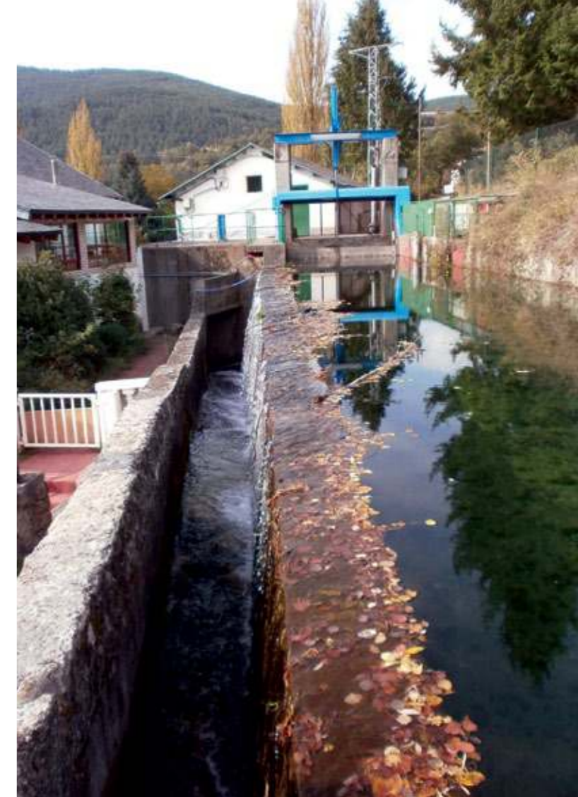
Cámara de carga de la central de Aratores, con el aliviadero (FIG. 19).
