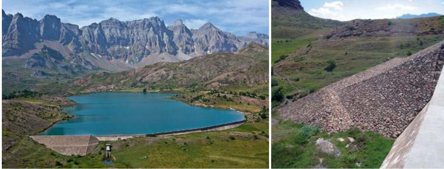
Presa de Tramacastilla de hormigón y terminada en escollera (FIG. 48). Transición de presa de hormigón a presa de escollera (FIG. 49).
