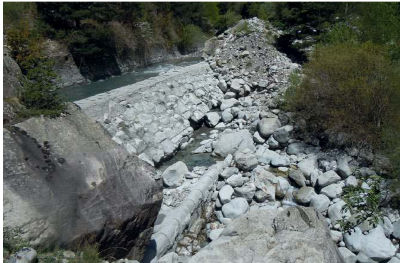
Azud de desvío del río Barrosa para canalizarlo a la cámara de carga del canal de Bielsa (FIG. 18). Puede verse que está pendiente de reparación el pie del azud. (dcha.) Cámara de carga del canal de Bielsa que recibe el desagüe de Barrosa (FIG. 17).
