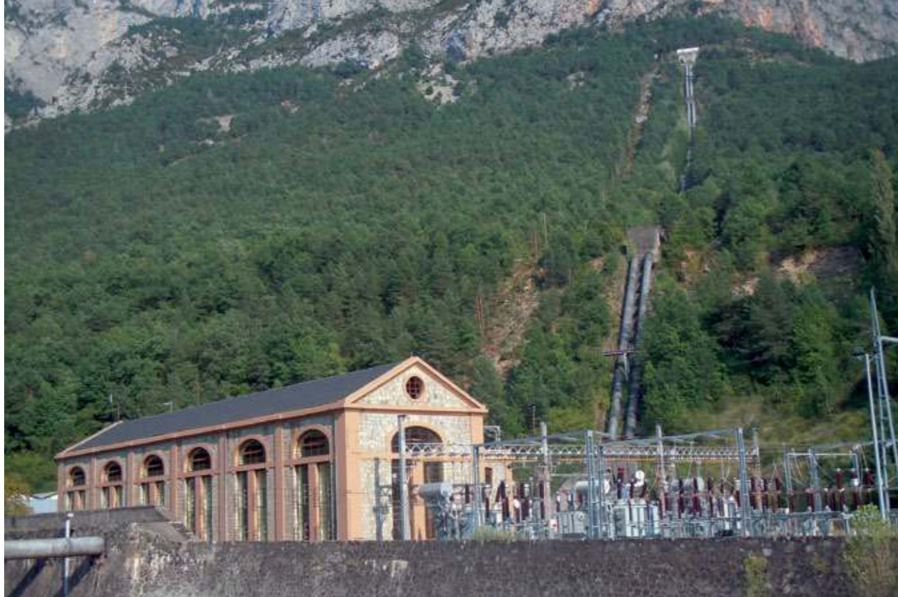
Central Lafortunada, tuberías de presión de la toma del Cinqueta con 360 m de salto y paso del río de las tuberías del Cinca (FIG. 34).
