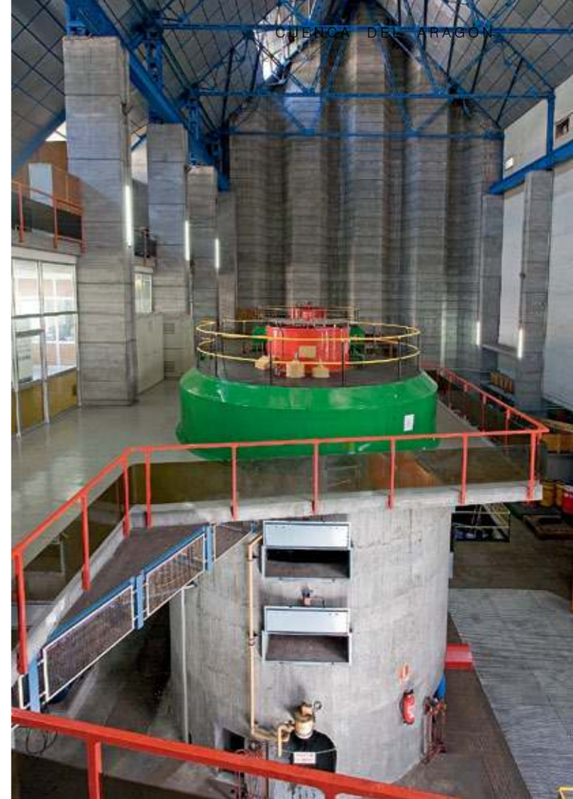
Interior de la central de Ip. Las turbinas quedan por debajo de la solera de la nave (FIG. 10).
