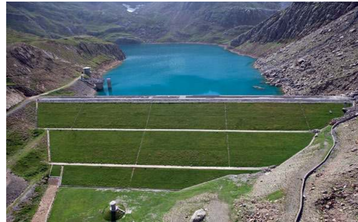
Presa de Ip en verano. Puede verse la torre de acceso a la galería aguas abajo de la presa (FIG. 03).
