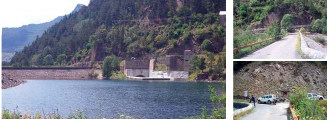
Estribo derecho de la presa de La Sarra en roca (FIG. 35). Estribo izquierdo de la presa de La Sarra en morrena (FIG. 36). Aliviadero y toma de la presa la Sarra en el estribo derecho, en roca (FIG. 37).
