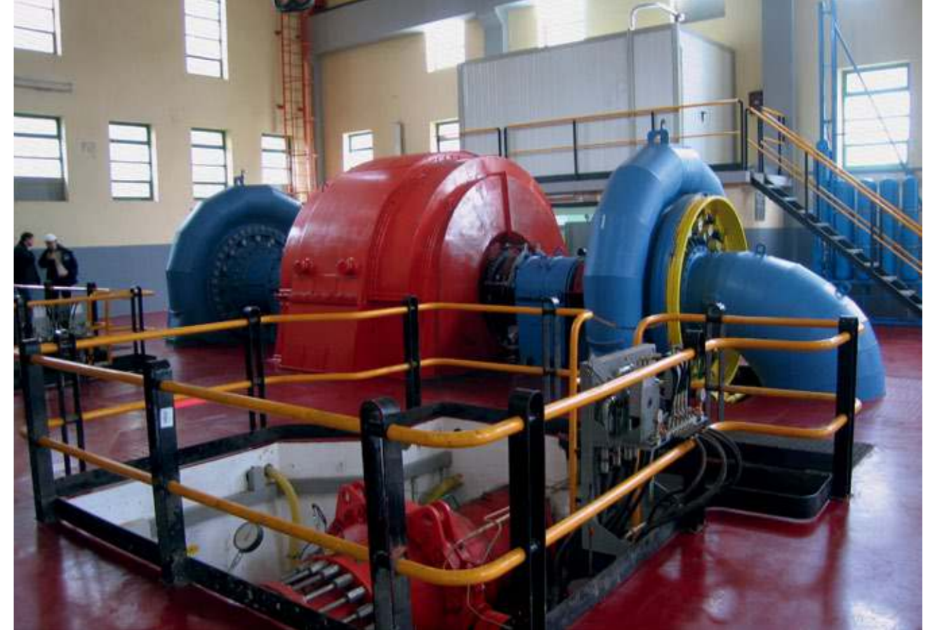
Interior de la central de Villanúa, con dos turbinas acopladas al mismo generador (FIG. 17).
