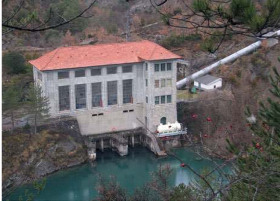
Exterior de la central de Argoné con el desagüe al embalse la presa de Campo (FIG. 27).
