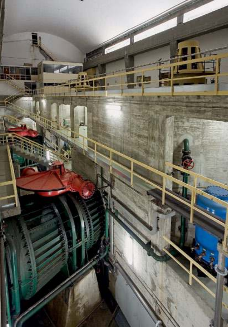
Central de Mediano, pueden verse los niveles del generador, eje y, en la parte baja el piso de turbinas con la tubería de carga (FIG. 50).
