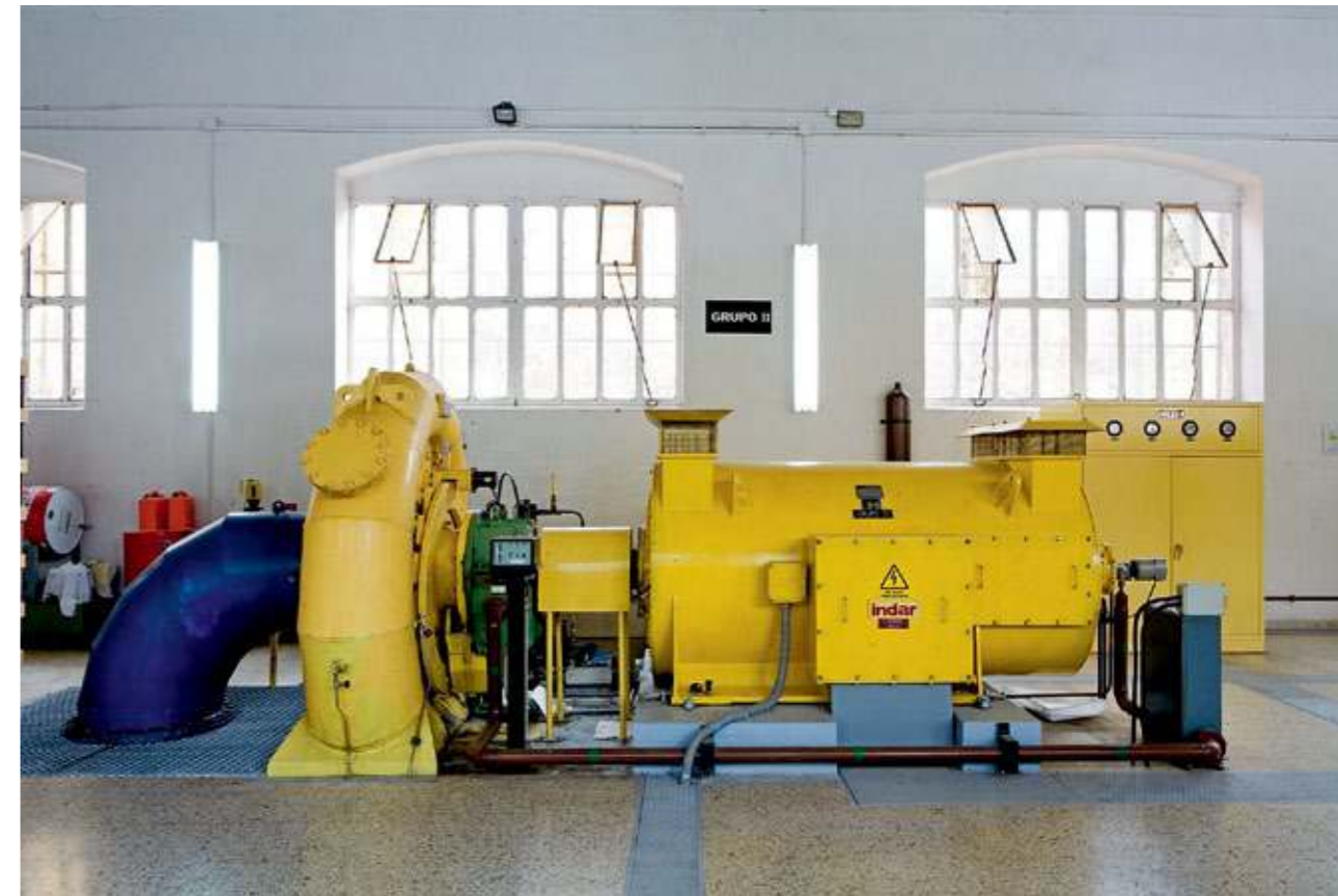
Grupo de Biescas I, con turbina Francis de eje horizontal (FIG. 59).
