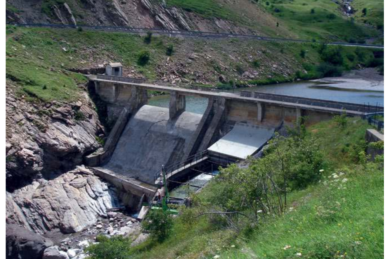
Presa de El Gállego, embalse y toma (FIG. 38).
