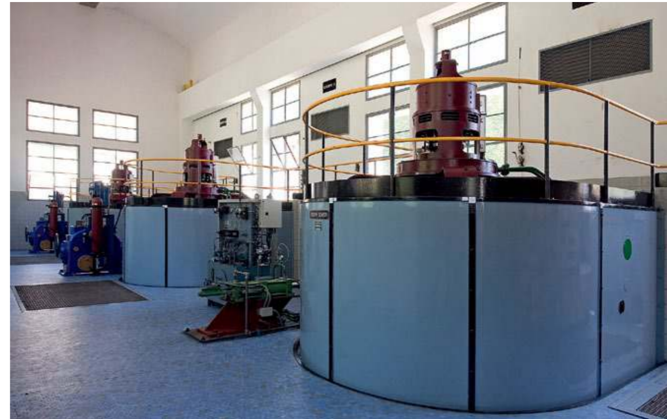
Equipos de las centrales de Sallent y Escarra (FIG. 56).
