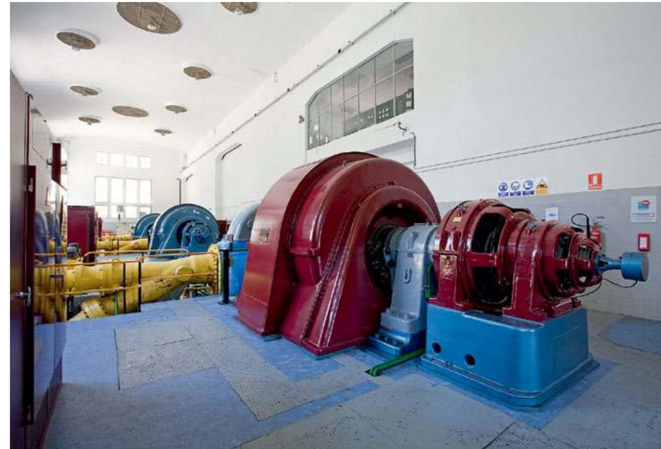
Interior de la central de La Sarra con tres turbinas Pelton. Véase el dimensionado de las bridas (FIG. 33).
