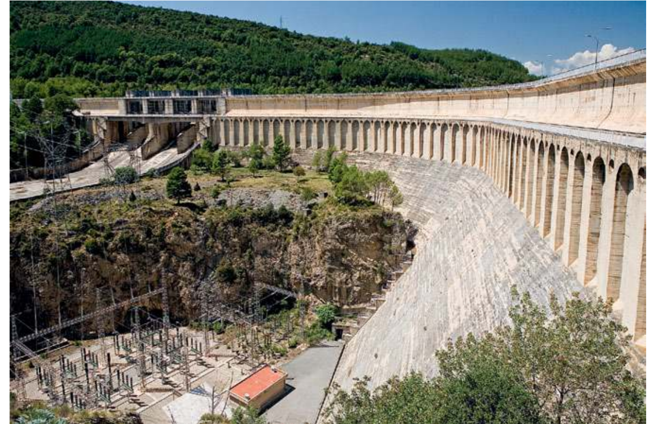
Presa de Mediano vista desde el estribo izquierdo (FIG. 48).
