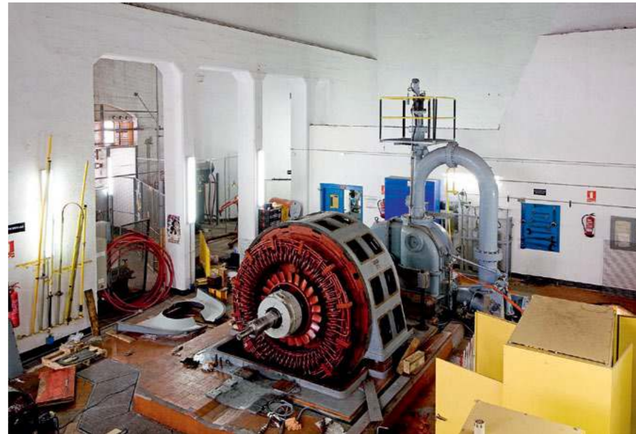
Interior de la central de Baños con el generador en trabajos de mantenimiento. Al fondo se ven los equipos eléctricos (FIG 19).
