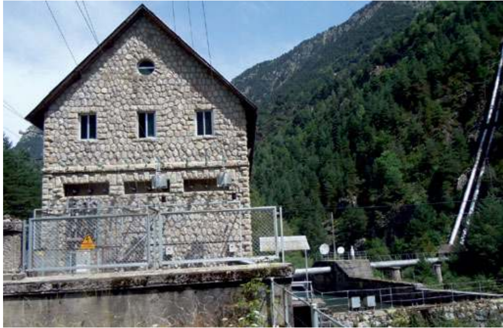
Central de Barrosa con la cámara de carga del canal a Bielsa (FIG. 15).
