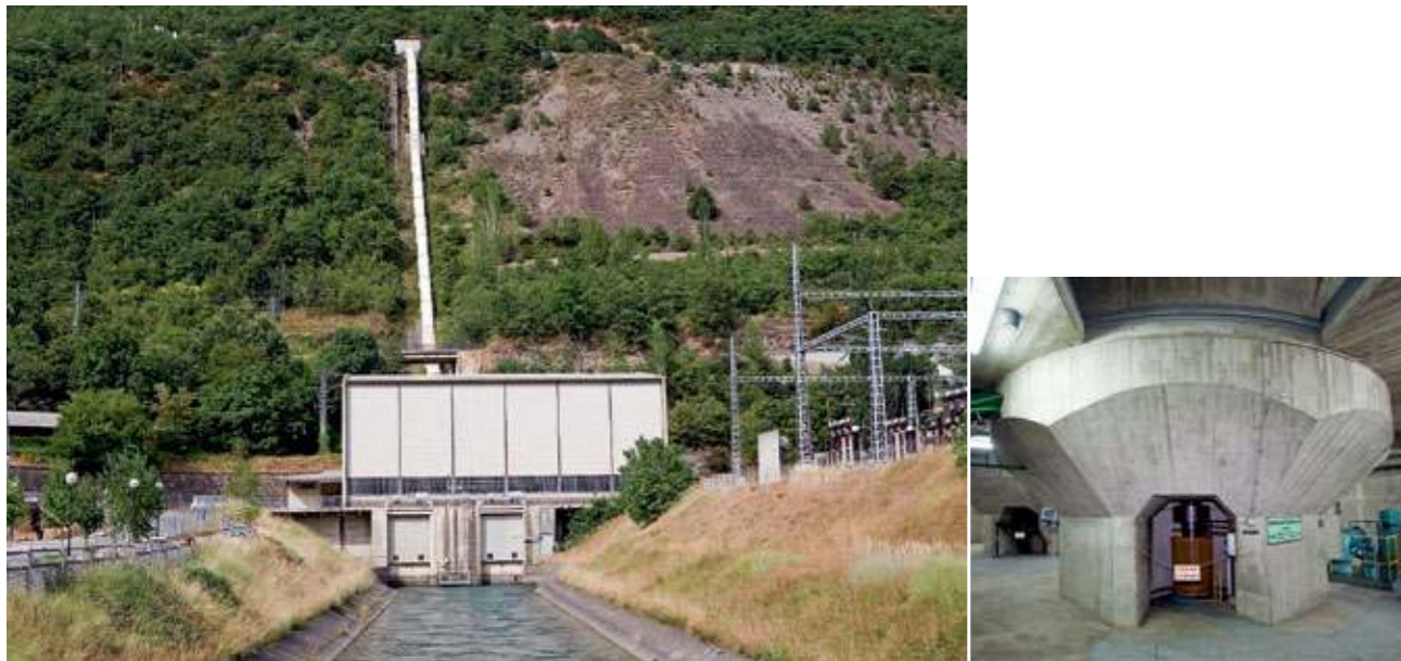
Tubería, central y canal de desagüe de Biescas II (FIG. 72). (dcha.) Estructura de soporte del piso de generadores con el eje de la transmisión en el interior (FIG. 74).
