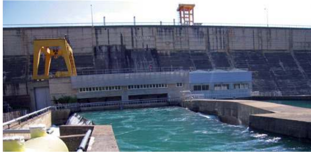
(arriba) Presa de El Grado, central de Grado I e inicio del canal del Cinca (FIG. 53).
