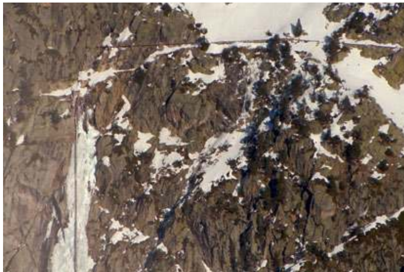
Parte alta y tramo horizontal de la tubería de presión (FIG 17).
