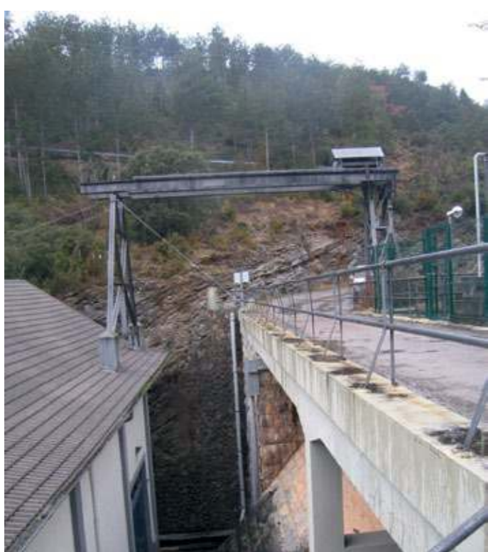
Puente grúa para bajar los equipos a la entrada de la central desde la coronación de la presa (FIG. 31). (dcha.) Presa y central de Campo, vertiendo por el aliviadero y el morning-glory (FIG. 30).
