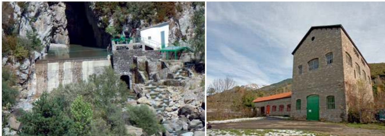
Azud de Santa Elena, toma de la central de Biescas I. La toma y la escala de peces están en la margen izquierda (FIG. 57). (dcha.) Exterior de la Central de Biescas I (FIG. 58).
