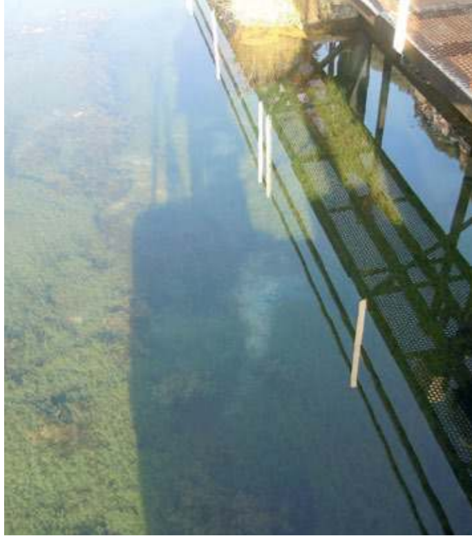
Aterramiento del embalse de Pineta que llega a las proximidades de las compuertas abatibles (FIG. 25).
